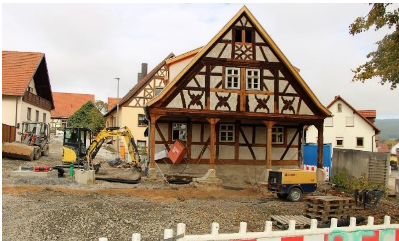
Abbildung 4: Sanierungsmaßnahmen an der alten Schmiede in der Ortsmitte von Happertshausen. Bild:Gerhard Schmidt.
