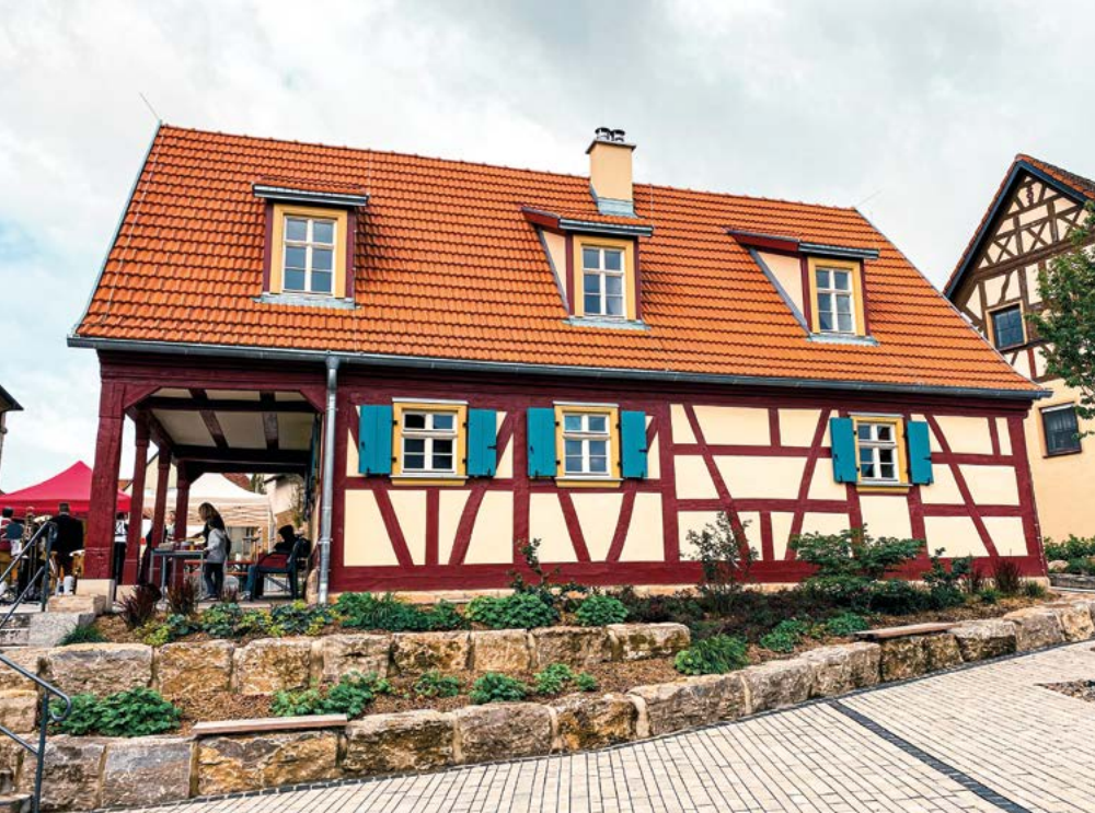
Sanierte Alte Schmiede Hapertshausen, Foto: Kreisentwicklung Haßberge
